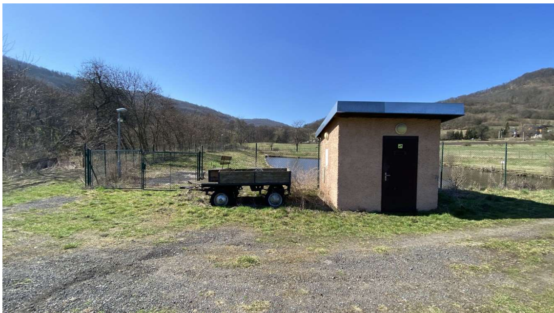
Stavba na parc. č. st. 55
