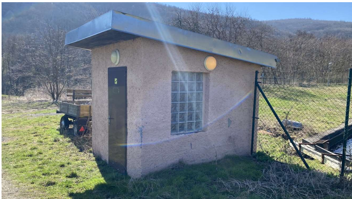
Stavba na parc. č. st. 55
